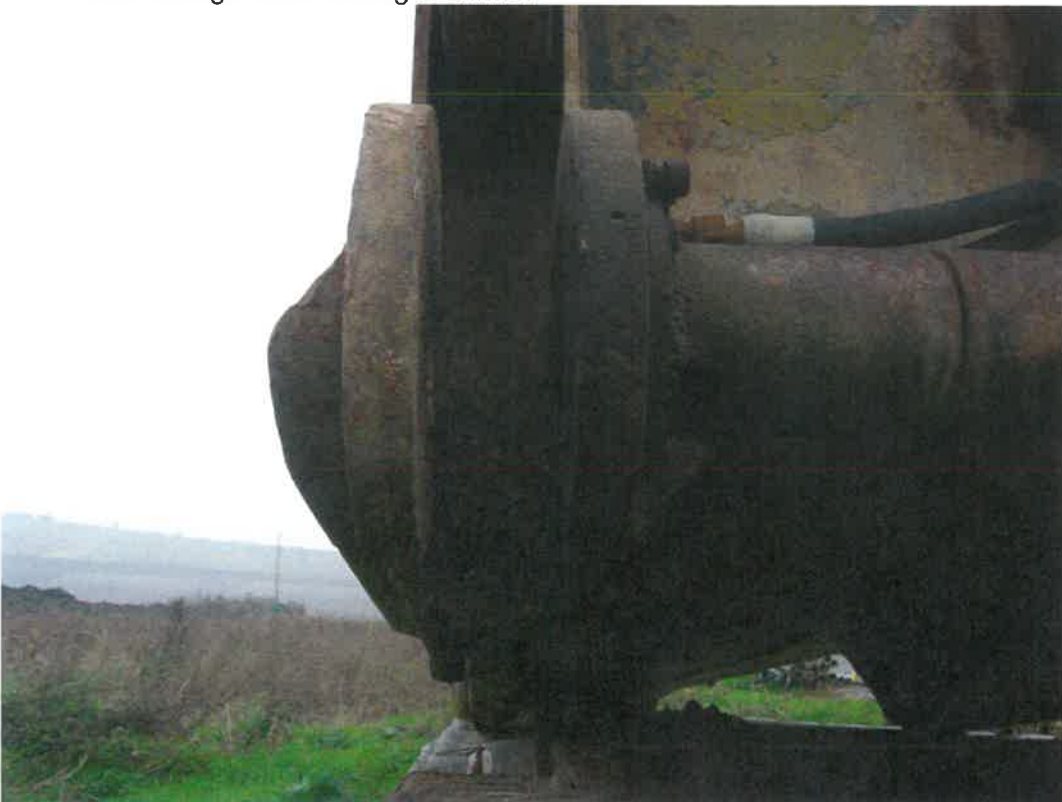
Bolzenauge zweischnittig t = 31\text{mm}
